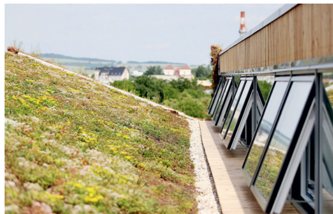
3 Šedová střecha je pokryta extenzivní zelení, která zachycuje dešťovou vodu, brání přehřívání vnitřního prostředí i samotné konstrukce haly a zároveň ochlazuje vzduch, jenž proudí okny do interiéru.
