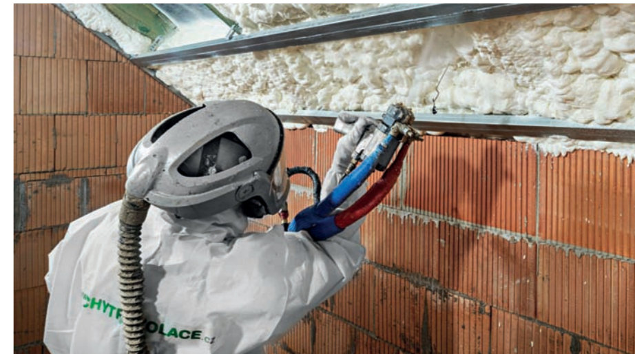
GERO-TEX PRO ZDIVO. Pěna Icynene, která se chová podobně jako známý materiál pro sportovce – proupuští ven páru, ale nepouští dovnitř vodu – firma nabízí od roku 2006.
