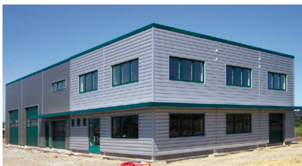
1 Dokonalé zateplení a opláštění energeticky úsporné budovy.
